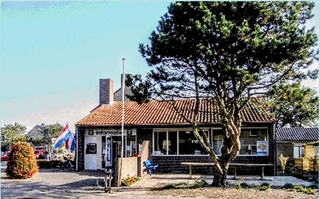
Afb.10. Het bestaande DOP-gebouw werd door toenemende bezoekersaantallen te klein.
